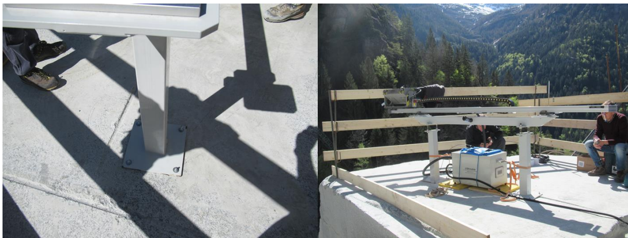
Figura 9: A sinistra, dettagli del basamento roccioso a cui è stato fissato il portale in metallo e a destra come appariva il sistema ad installazione ultimata.
